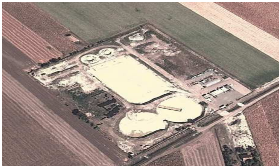
PPOV VRBAS+KULA (u izgradnji)
