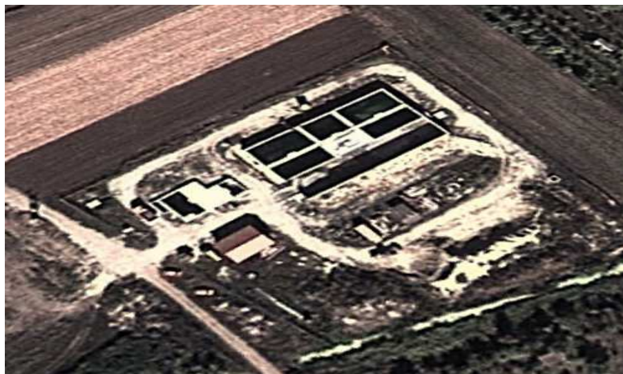
PPOV RUMENKA (u izgradnji)
